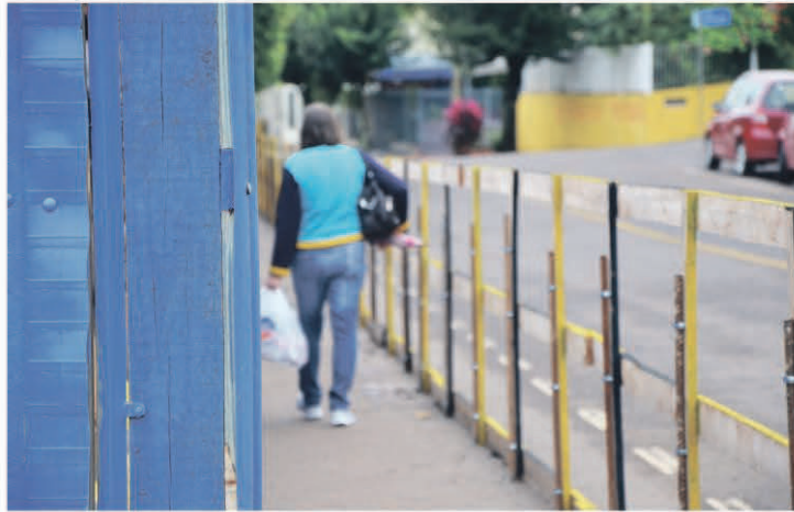
Tapumes na rua Coelho Neto são questionados por moradores. Construtor fala da necessidade de amenizar os riscos no local
