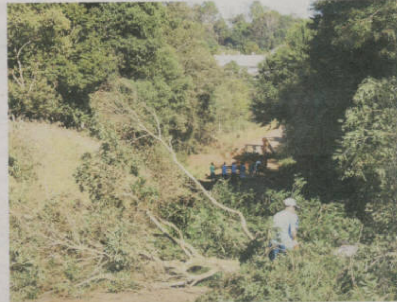
Nesta semana, foi realizada a limpeza da via com a retirada da vegetação
