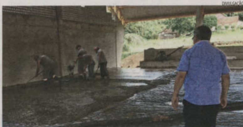
No dia 9, prefeito Marasca acompanhou concretagem da quadra
