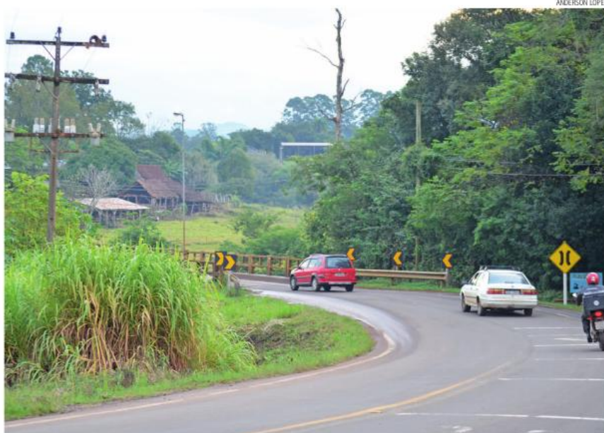
Poste de alta tensão que leva energia para o bairro São Bento é o único instalado no lado oposto da via
