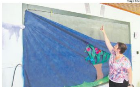
PREJUÍZO: coordenadora Marcela Eneida Hoppe mostra local onde estava instalado ar-condicionado que foi furtado
