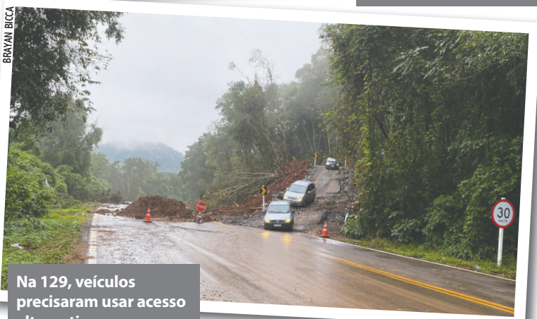
Avanço das águas impediram trabalhos para liberação do trânsito na ponte sobre o Arroio Boa Vista
