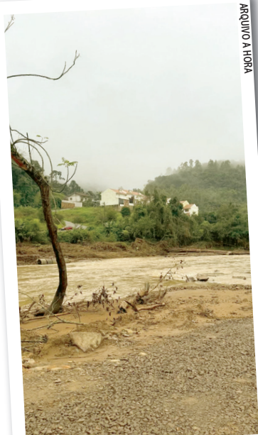
Estrutura construída recentemente foi levada pela força do Arroio Forquetinha
