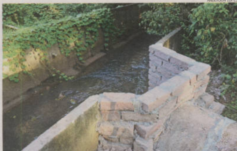
Trecho de 400 m do Arroio do Engenho será canalizado e coberto com bloquetes
