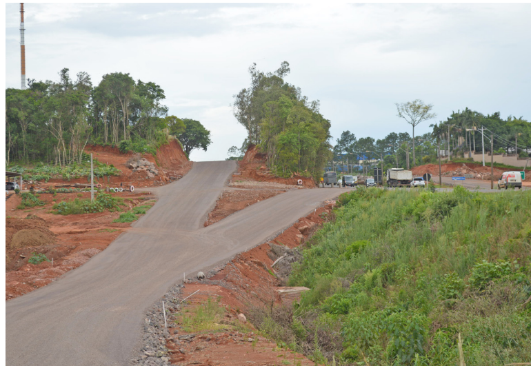
Ruas laterais serão liberadas para o trânsito devido ao avanço da obra
