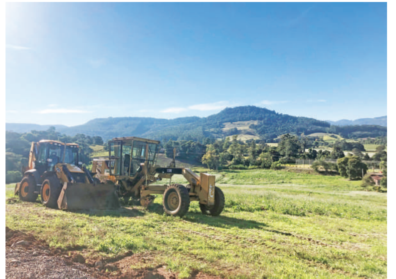
A subestação será construída em uma área na Vila Storck, na rua Arnoldo Alfredo Scherer, em Forquetinha
