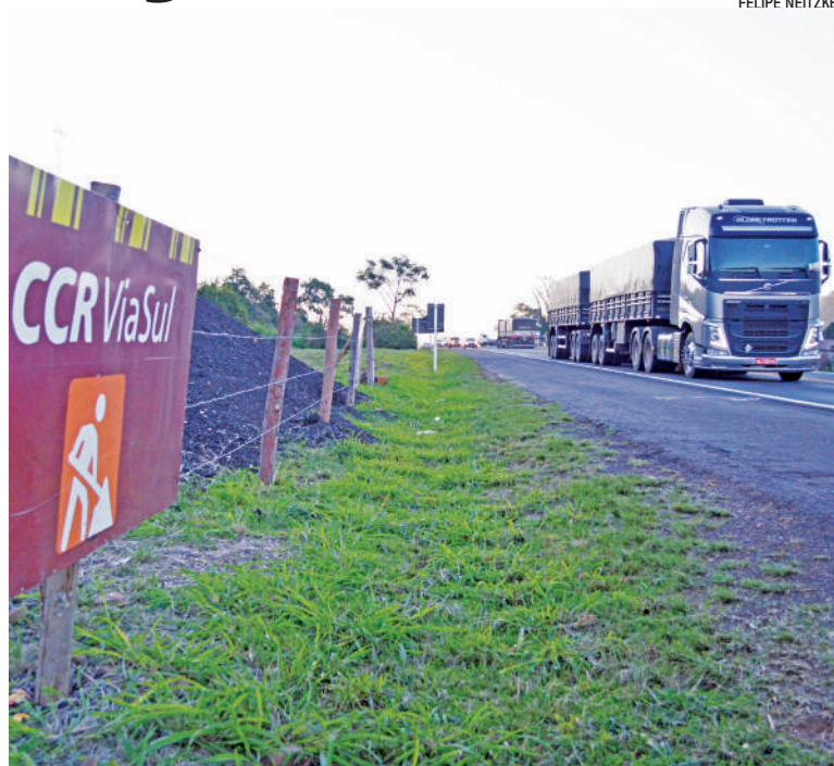
CCR Viasul contratou empresa terceirizada, a Eurovias, para fazer o preparo da obra. Equipes estão em Marques de Souza
