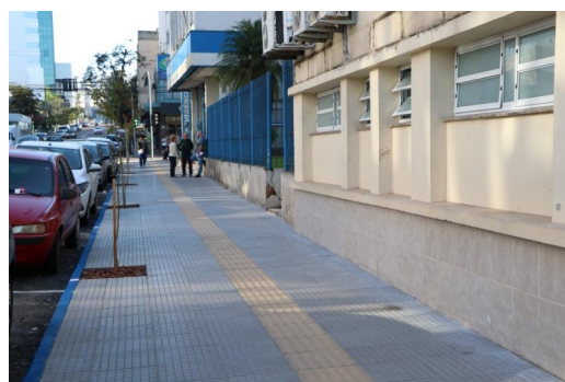
Figura 19: Reforma completa da calçada de passeio;
