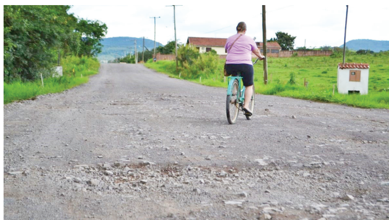
Estado repassou cerca de R$ 9 milhões para obra por meio do Avançar
