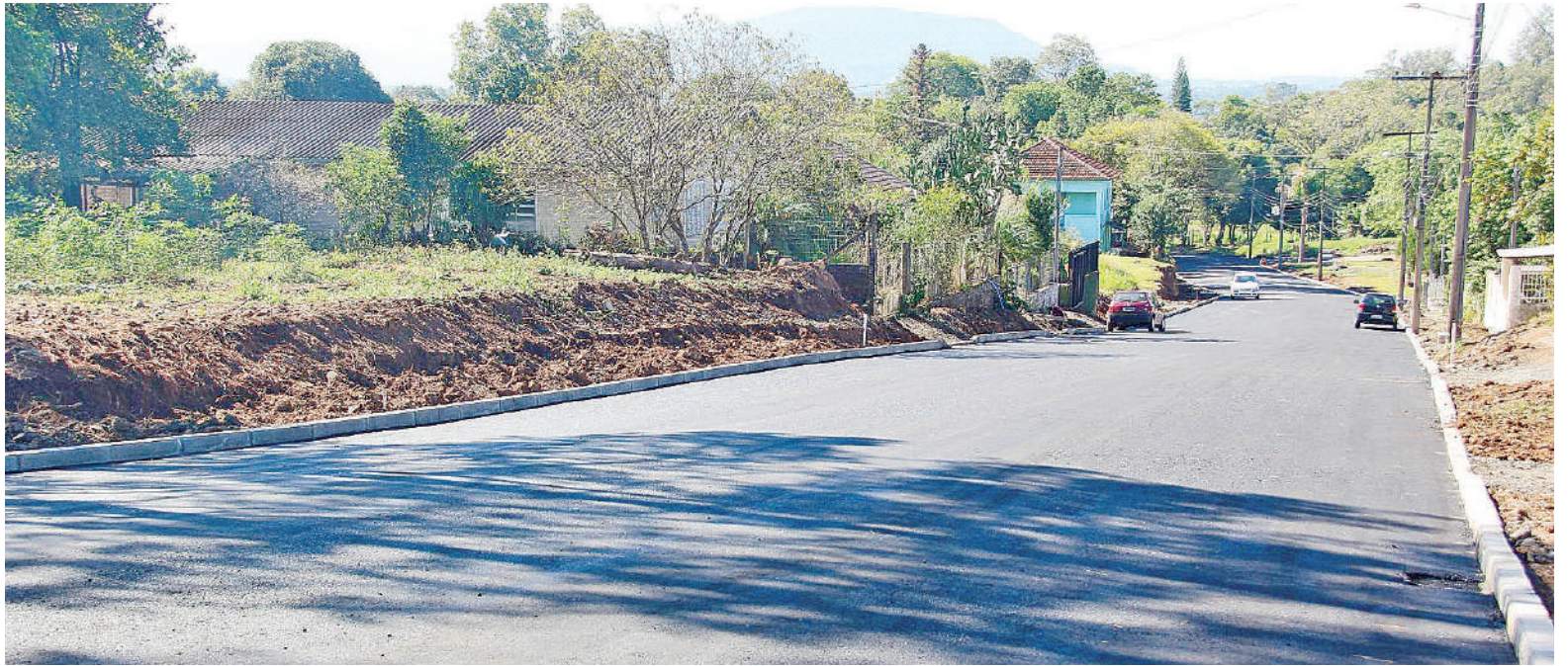
Pavimentação da Rua Rio Grande do Norte, no bairro Universitário, está pronta. Governo ainda precisa concluir meio fio e calçada
