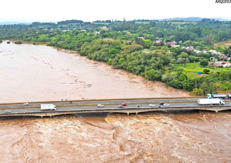
Água da enchente de setembro se aproximou da pista na ponte da BR-386
