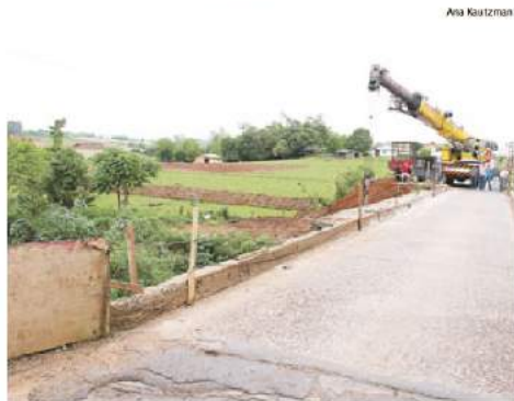
INTERDITADA: obra na ponte sobre o Arroio Saraquá está 70% concluída
