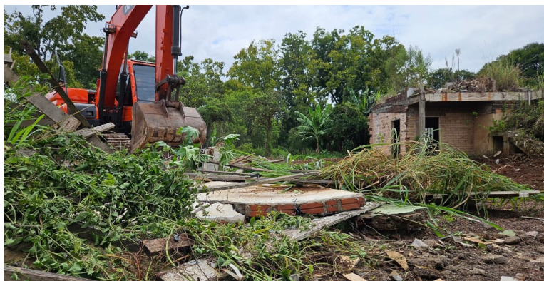
Equipamentos destruíram o que ainda existia de moradias no local, escombros ficarão onde eram as casas até uma destinação definitiva
