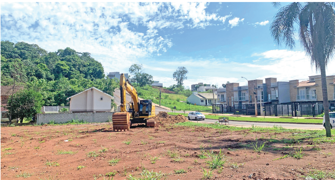
Trabalhos de limpeza da área iniciaram no ano passado, agora, avança para terraplanagem
