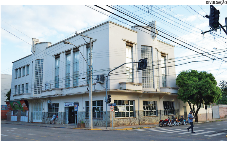
Prédio hoje é ocupado pela estrutura da Secretaria de Desenvolvimento Social. No imóvel, também funciona um restaurante
