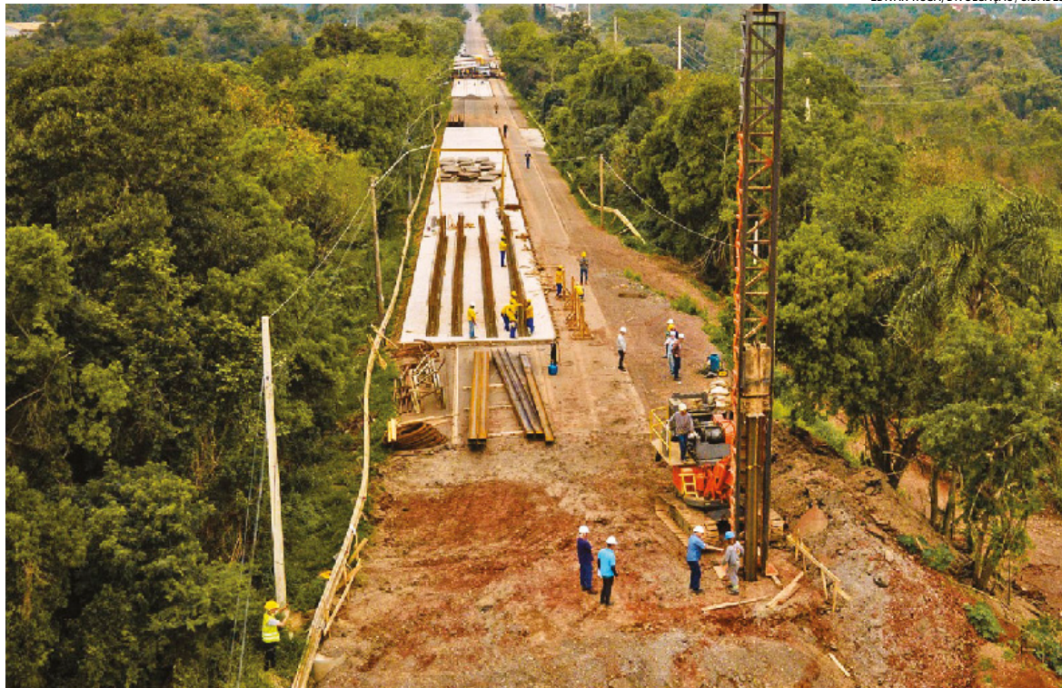
No Vale do Taquari, região fortemente atingida, ponte sobre o Rio Forqueta é aguardada para dezembro
