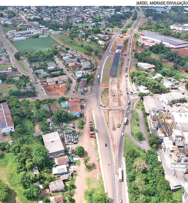
Obras avançam para etapa final. Previsão é entregar vias laterais e trincheira até março
