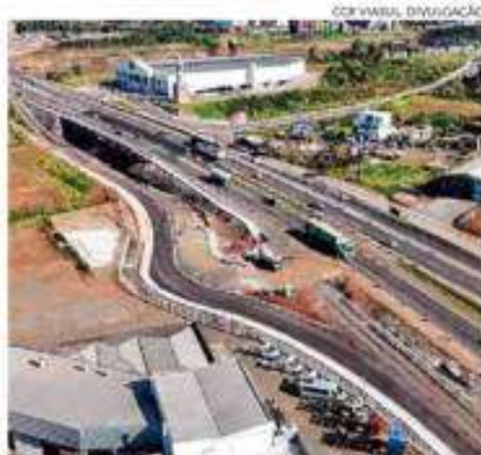
Estrutura situada na BR-386 passa por melhorias
