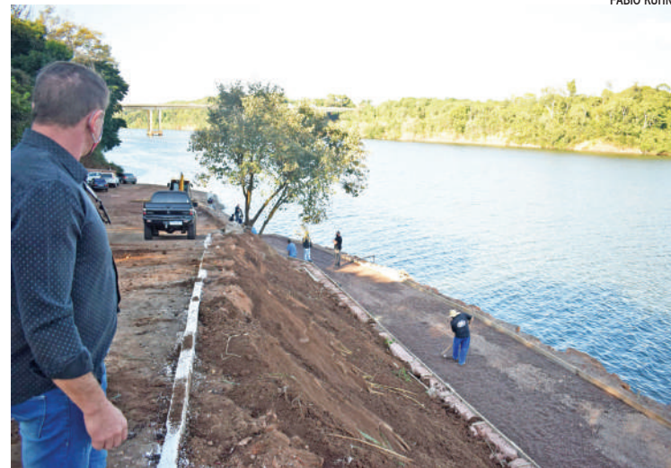
Nesta terça-feira, rampa de acesso ao rio recebe concretagem
