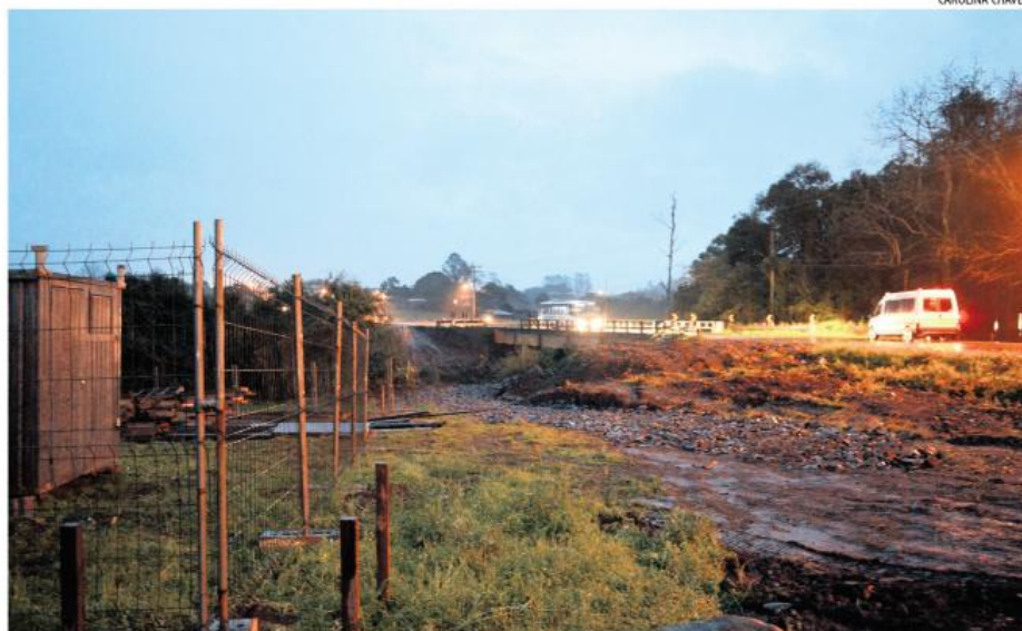
Canteiro começou a ser preparado nessa terça-feira após quatro meses da assinatura da ordem de serviço
