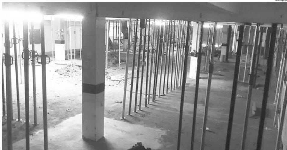
ESTRUTURA: pilares do Shopping Lajeado estão sendo reforçados. Promotoria acompanha a obra
