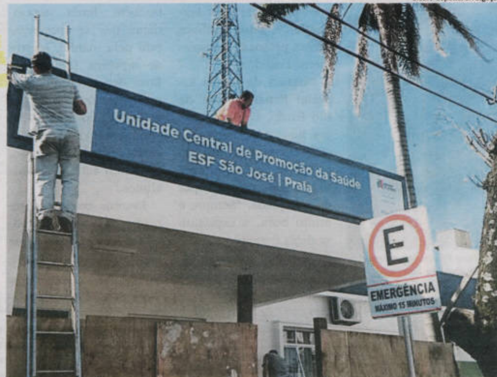
Município e União investem R$ 549 mil na reforma e ampliação do Posto do Centro
