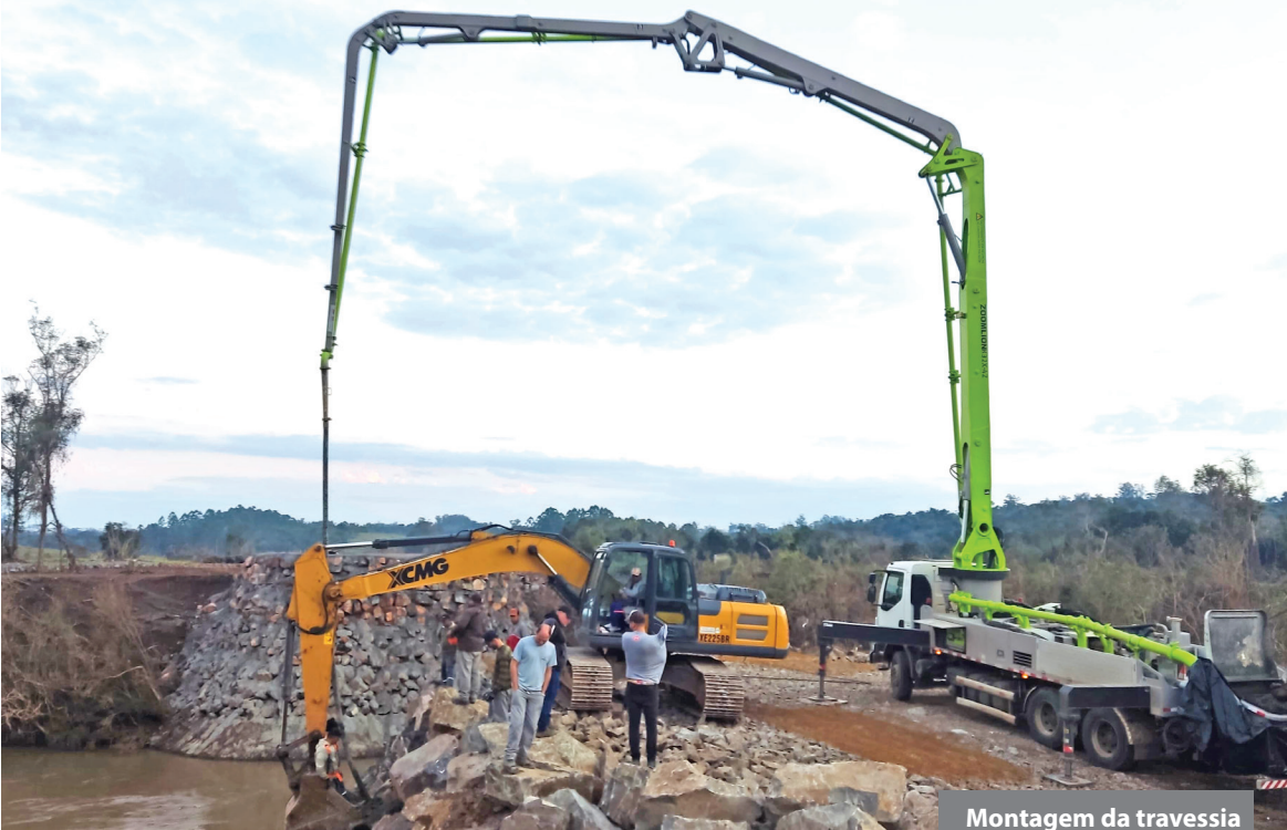
Montagem da travessia vai iniciar pelo lado de Lajeado
