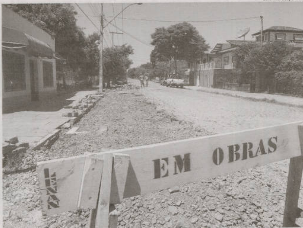
Obras na Rua Marechal Deodoro devem ser concluídas até o fim da semana
