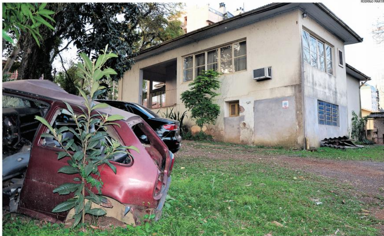
Prédio na esquina das ruas Saldanha Marinho e João Abott já foi sede da Sthas. Avaliado em mais de R$ 500 mil, virou depósito de sucatas
