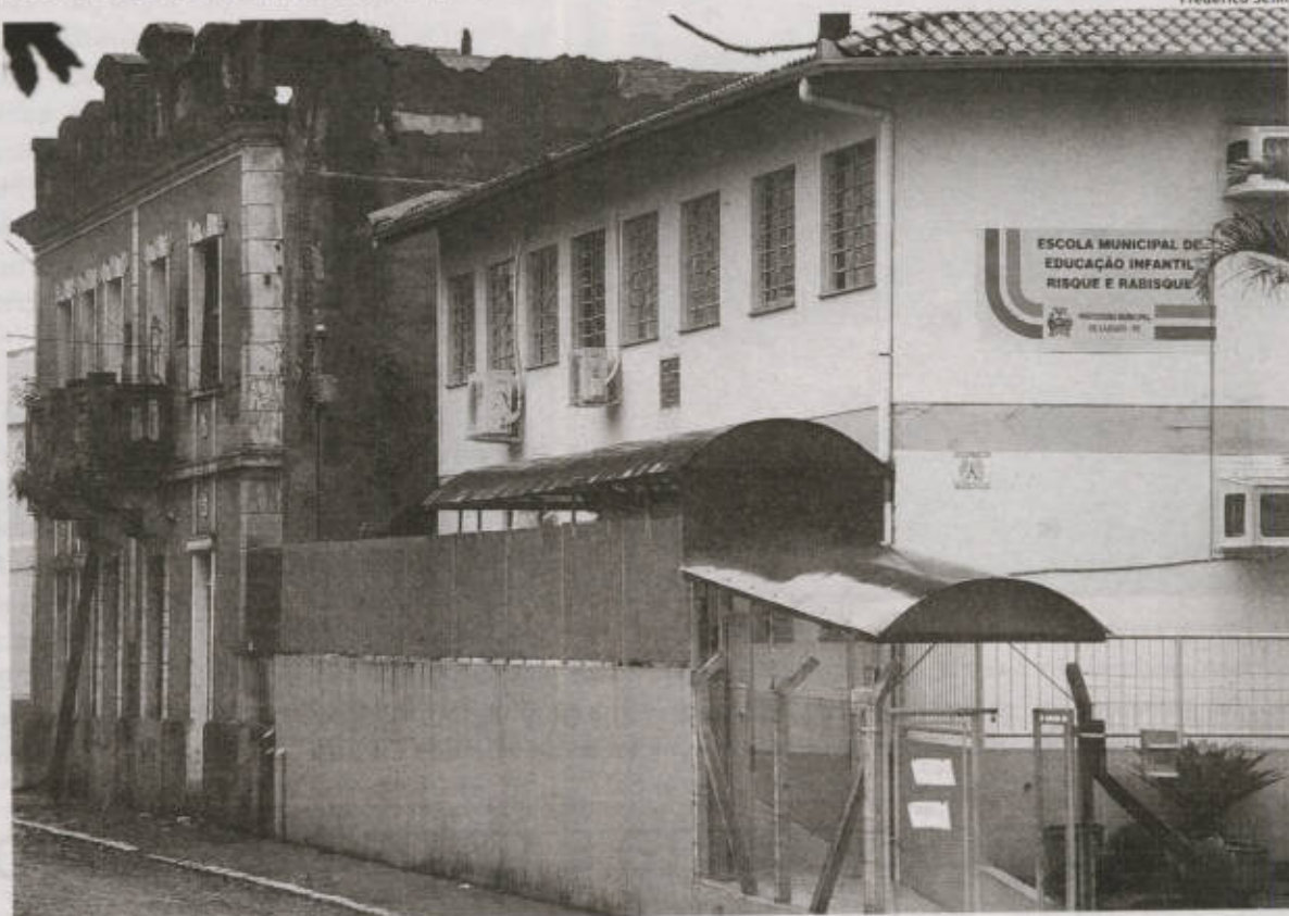
Prédio em ruínas causa transtornos à comunidade escolar ao lado
