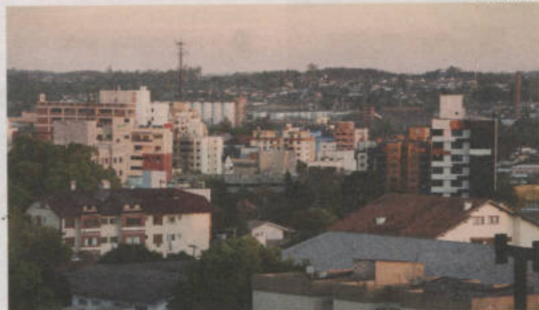
Empresa contratada pelo governo começou trabalho de vistoria ontem
