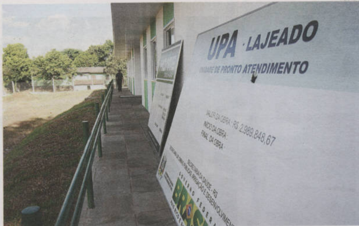
Governo prepara terreno e instalação do mobiliário. Nas próximos dias, chegam telefone, computadores e equipamentos
