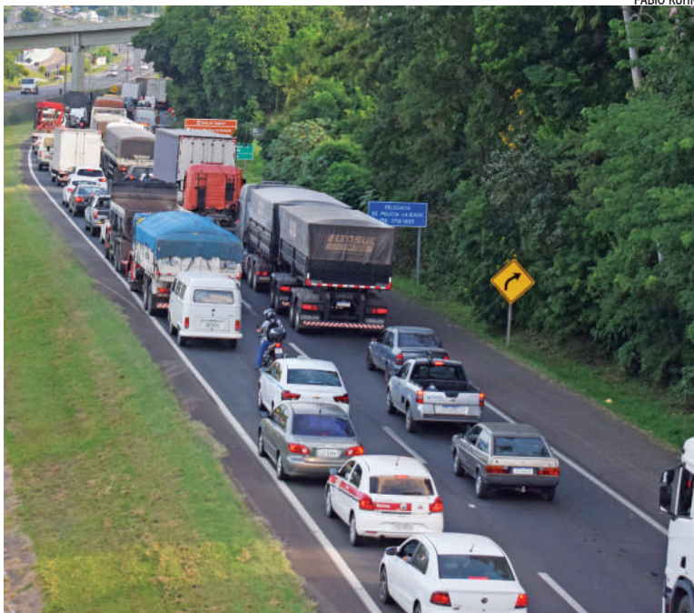
Congestionamento se tornou rotina na BR-386, entre Lajeado e Estrela, após a explosão que comprometeu uma das pontes do Arroio Boa Vista
