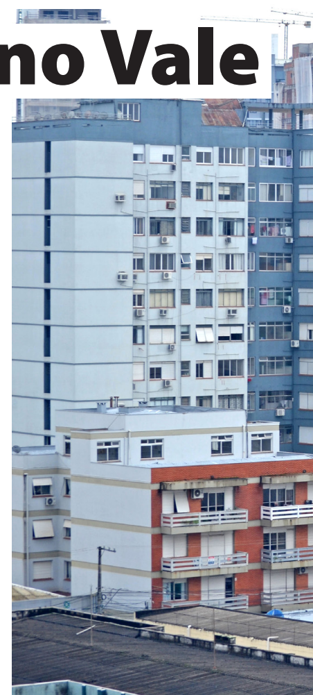
Verticalização é um dos indícios do crescimento de Lajeado, com o surgimento de mais prédios nos últimos anos
