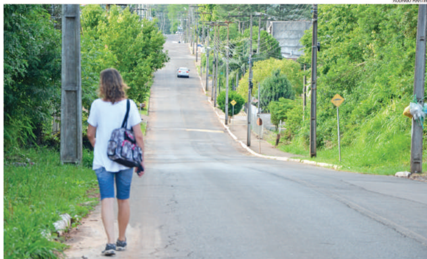
Em alguns trechos da Av. Alberto Pasqualini, no Universitário, a falta de calçadas coloca em risco os pedestres
