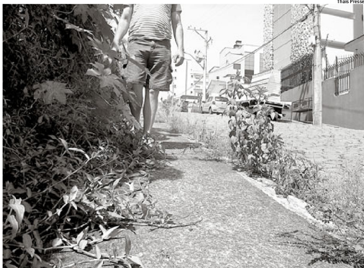
MAU EXEMPLO: na Rua Fialho de Vargas, no Centro, tanto a calçada como o meio-fio estão tomados pela vegetação
