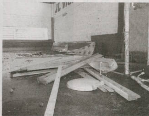
Banheiros e vestiários foram demolidos
