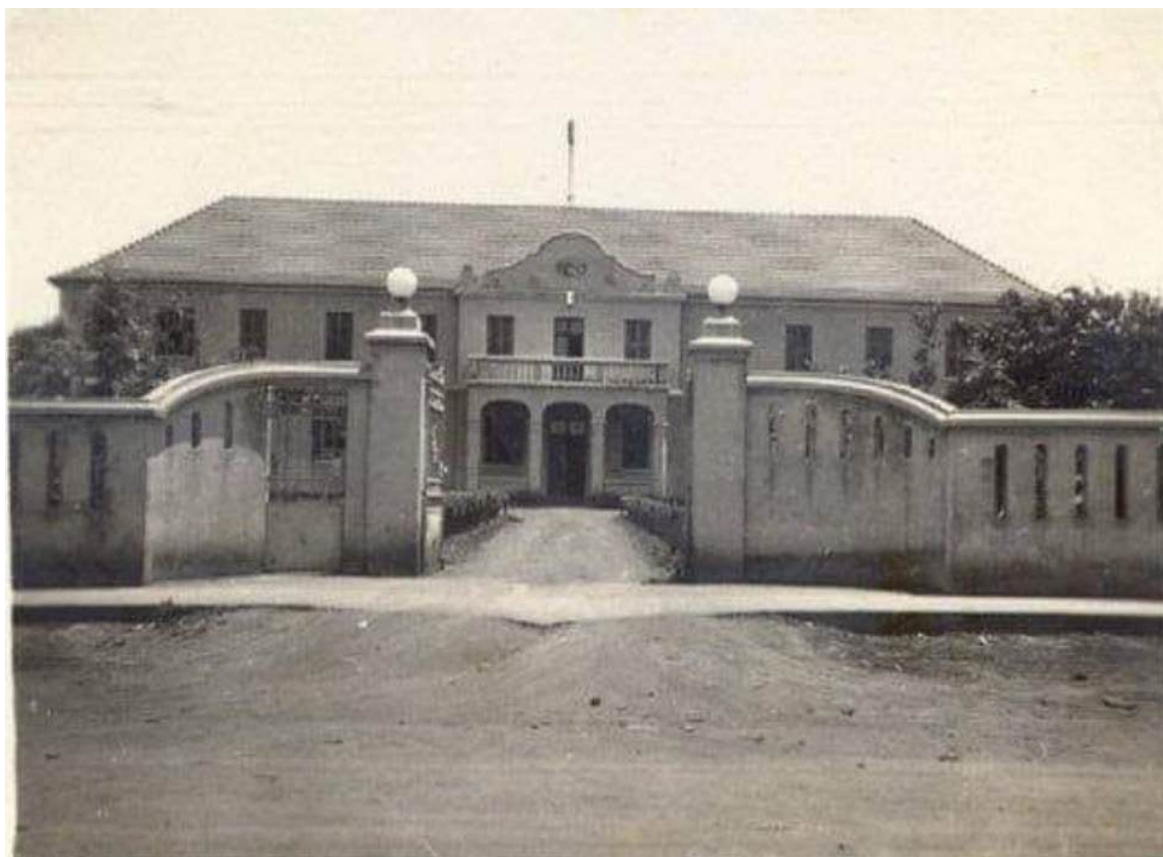
Estrutura do antigo Hospital São Roque
