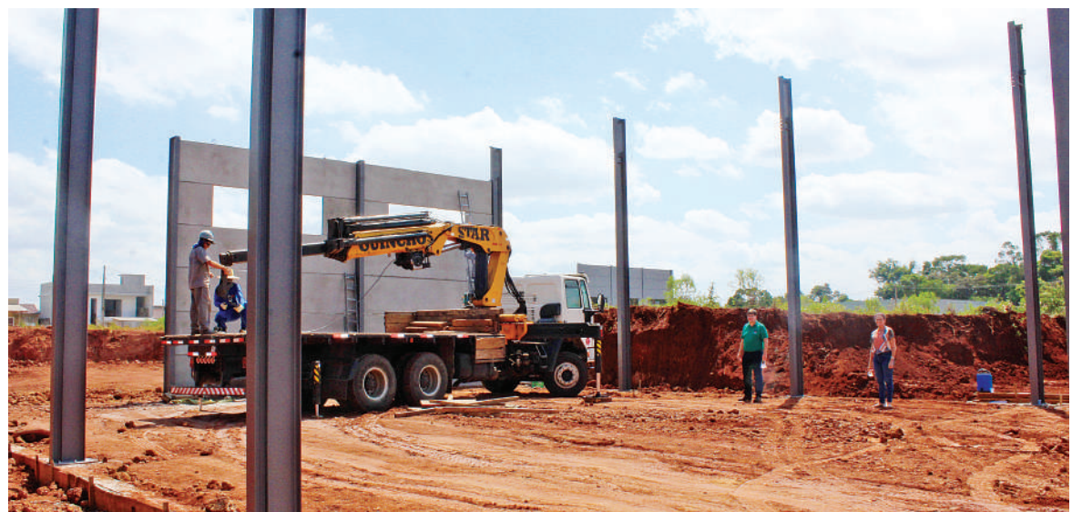
Empresas estão em fase de instalação no Loteamento Comercial e de Serviços Coxilha Vermelha
