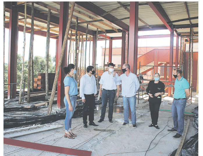
Obras da Unidade de Terapia Intensiva estão em andamento
